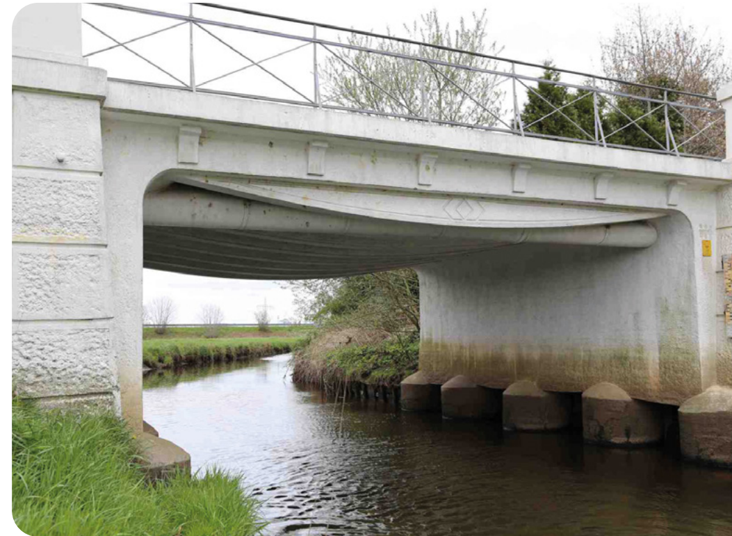
↑ Die Möller-Brücke in Kaaks-Eversdorf – eine der letzten noch intakten architektonisch interessanten Fischbauchbrücken Deutschlands.
