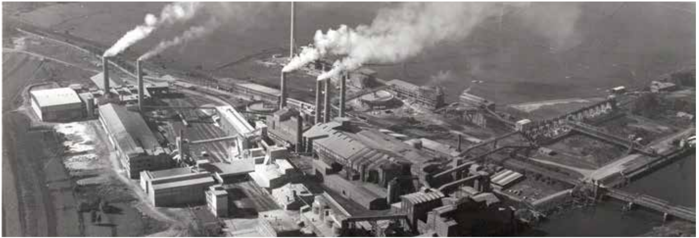
Luftaufnahme Alsenwerk Itzehoe (Foto: Kreismuseum Prinzeßhof)
